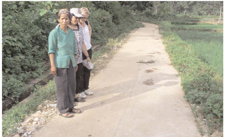
Un chemin carrossable se dirige vers le village, mais, faute de moyens financiers, les travaux se sont arrêtés 800 m avant le village.
